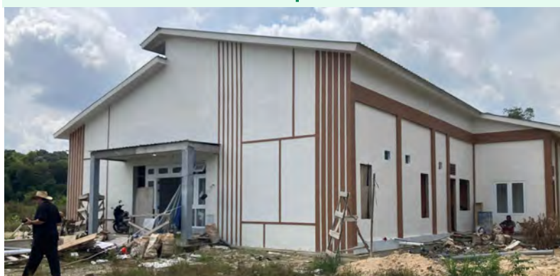
A punto de terminar la construcción de la casa de Balai
