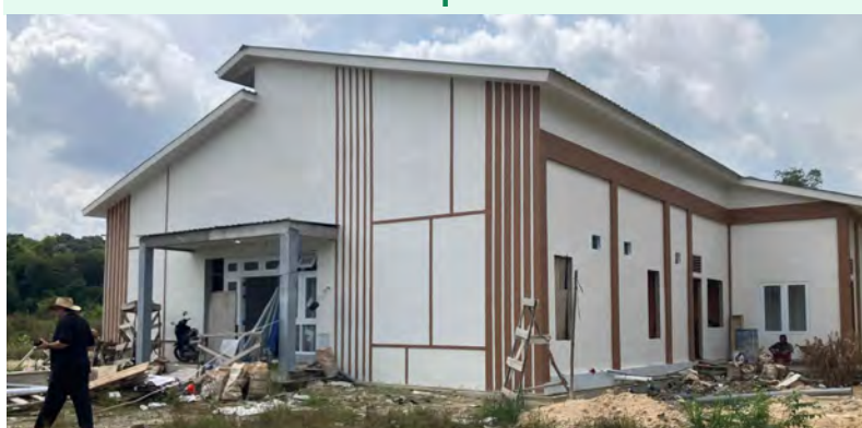
A construção da casa de Balai está quase concluída
