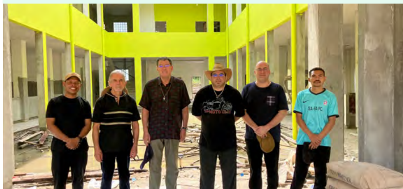
Visita ao canteiro de obras do internato Balai (ilha de Bornéu)
