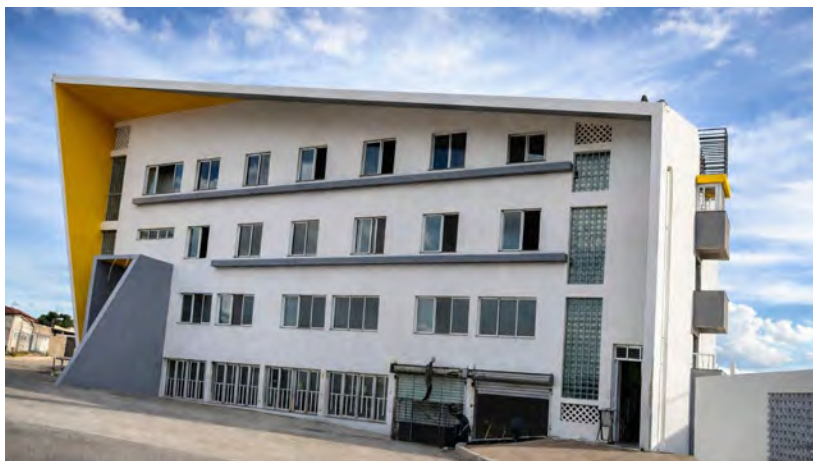
Fachada principal de la casa de formación de Huambo (Angola)
